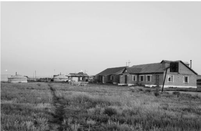
아름다운 몽골의 대자연 속에 세워진 믿음의 공전교회. 사진 좌측에 몽골 전통집인 게르가 보인다.
