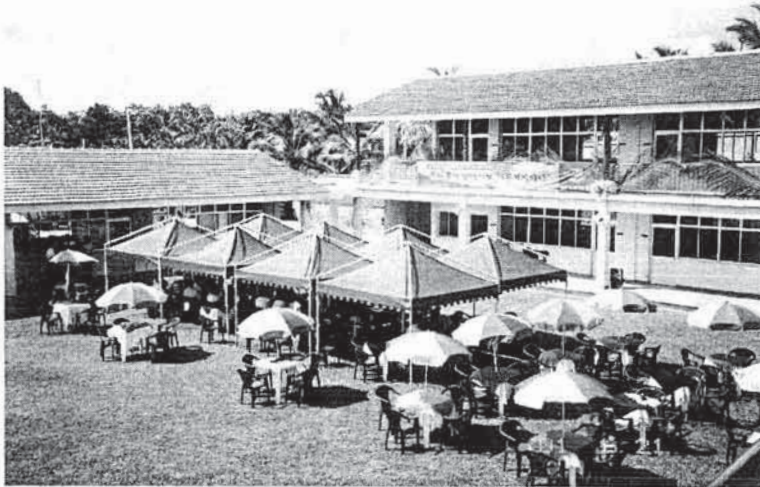
▲ 원경된 서남아 선교센터. 2층 건물 세 동에는 강의실, 교무실, 기숙사와 카페테리아가 들어 서 있다. 기술 및 언어학교와 서남아시아 복음화를 위한 선교베이스로 쓰이게 된다.
